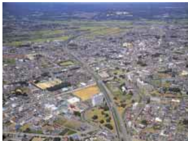
関越自動車道
