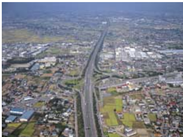
関越自動車道
