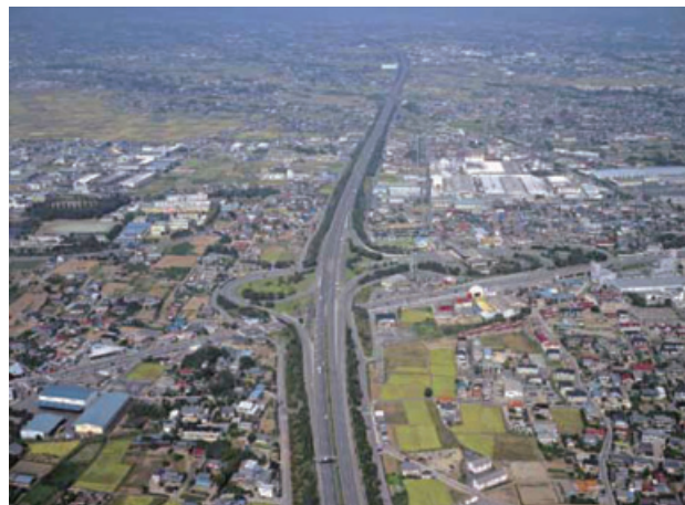
関越自動車道
