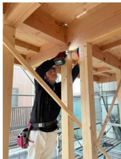
■ 実際の現場で作業する様子
