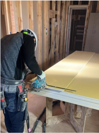
■石膏ボードのカットの様子
