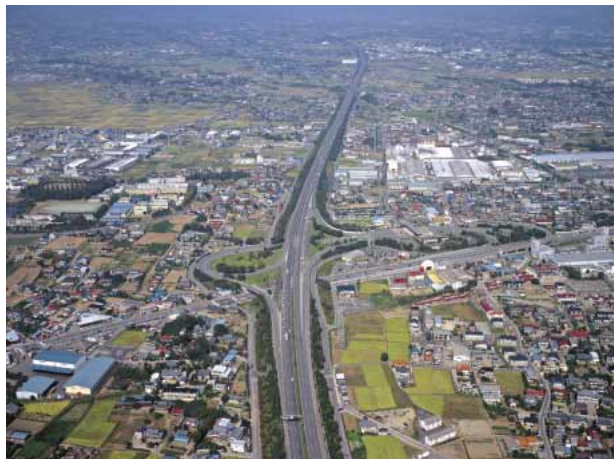
関越自動車道
