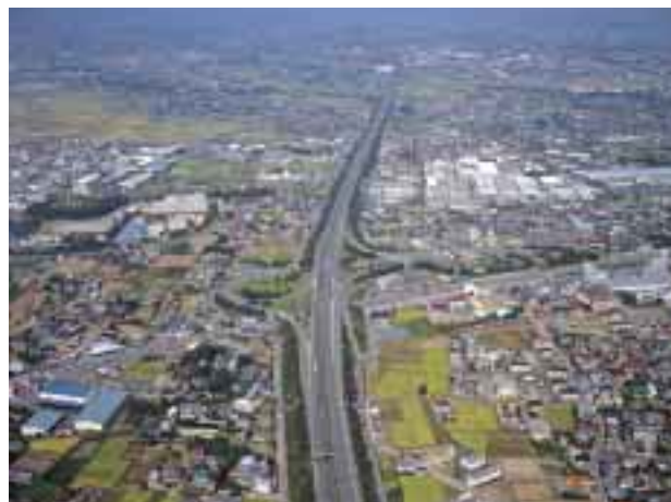
関越自動車道
