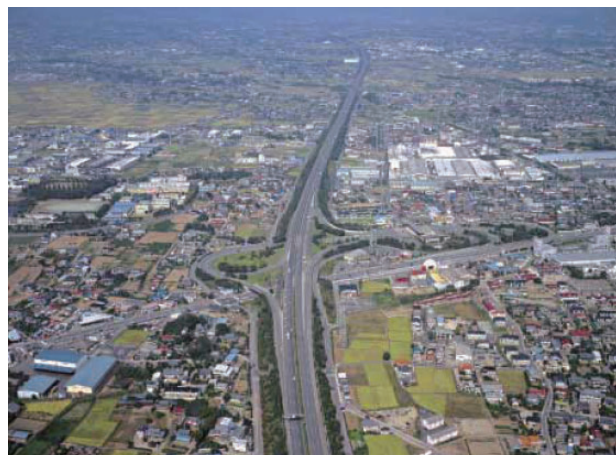
関越自動車道
