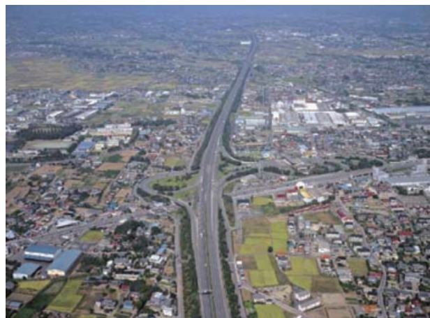
関越自動車道
