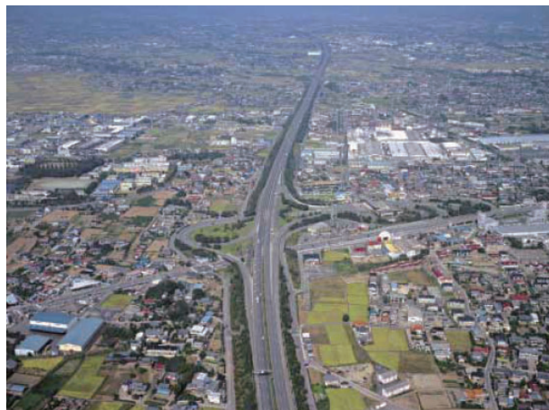
関越自動車道
