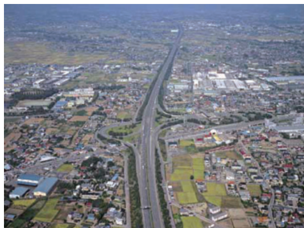
関越自動車道
