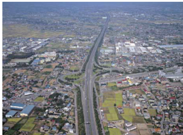
関越自動車道
