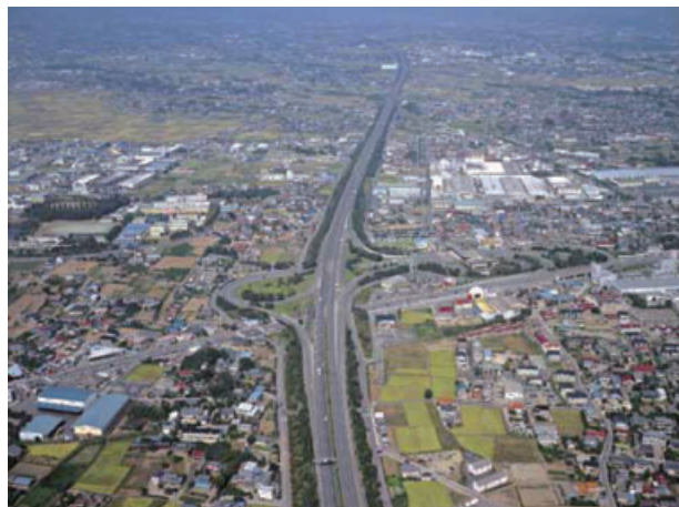
関越自動車道
